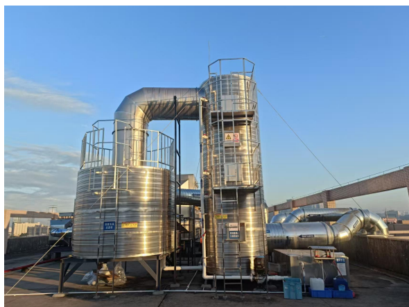
防堵塞离心分离吸收塔+深度洗涤过滤塔
