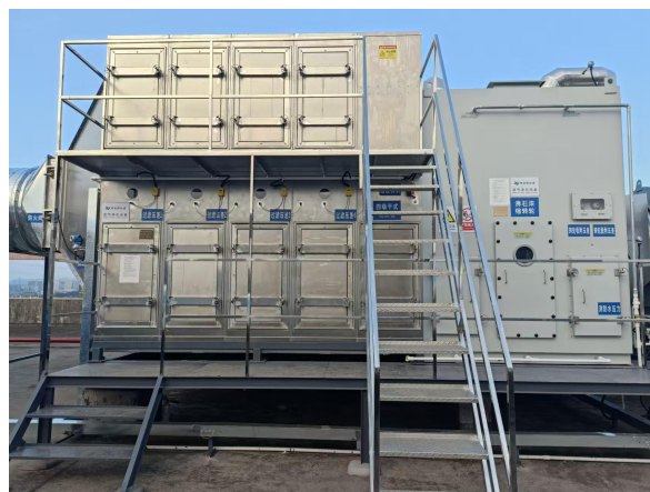
四级干式过滤装置+沸石转轮吸附浓缩
